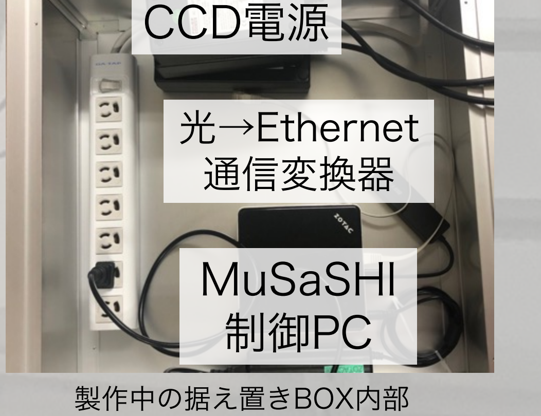
製作中の据え置きBOX内部
