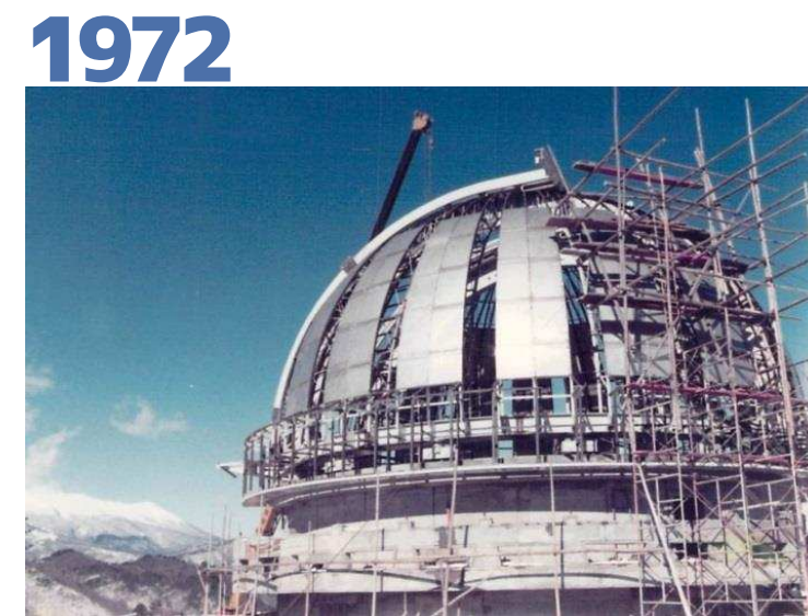
建設中のドームと御嶽山
