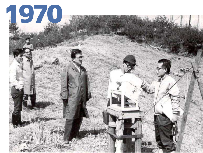
建設予定地の調査
